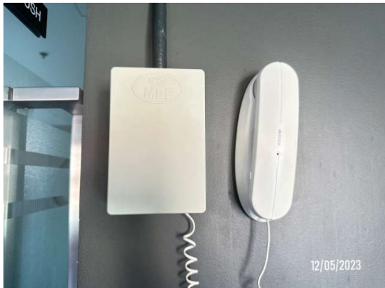
รูปที่ 2-40 โทรศัพท์แจ้งเหตุเพลิงไหม้
