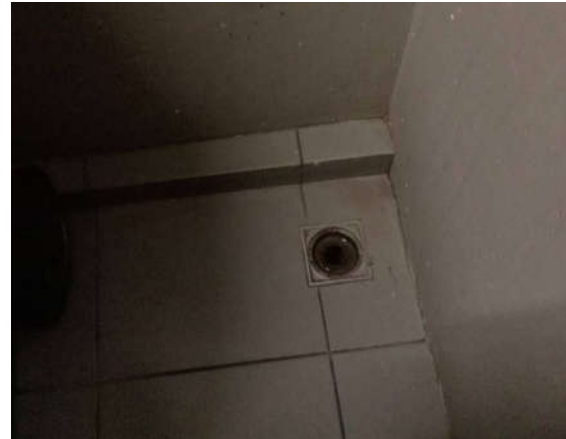
รูปที่ 2-28 ท่อรวบรวมน้ำเสียจากห้องพักมูลฝอย
