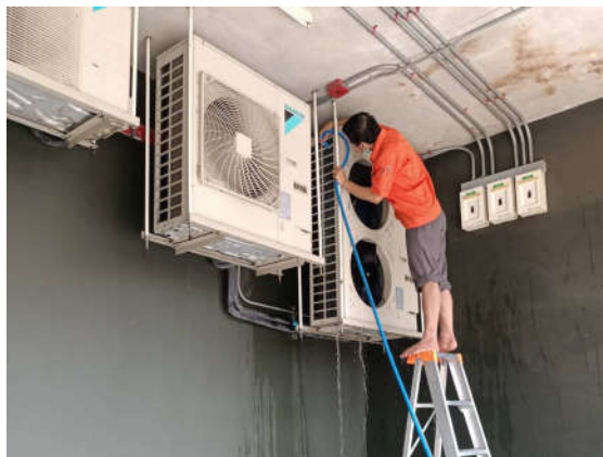
รูปที่ 2-35 ช่างซ่อม/ล้างเครื่องปรับอากาศ
