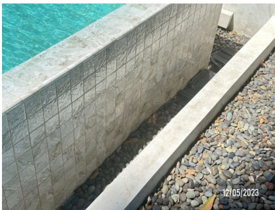
รูปที่ 2-23 รางระบายน้ำล้นรอบสระว่ายน้ำ
